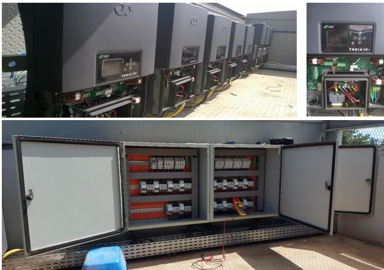
Foto 3 – Reaperto das conexões dos quadros elétricos e inversores.
