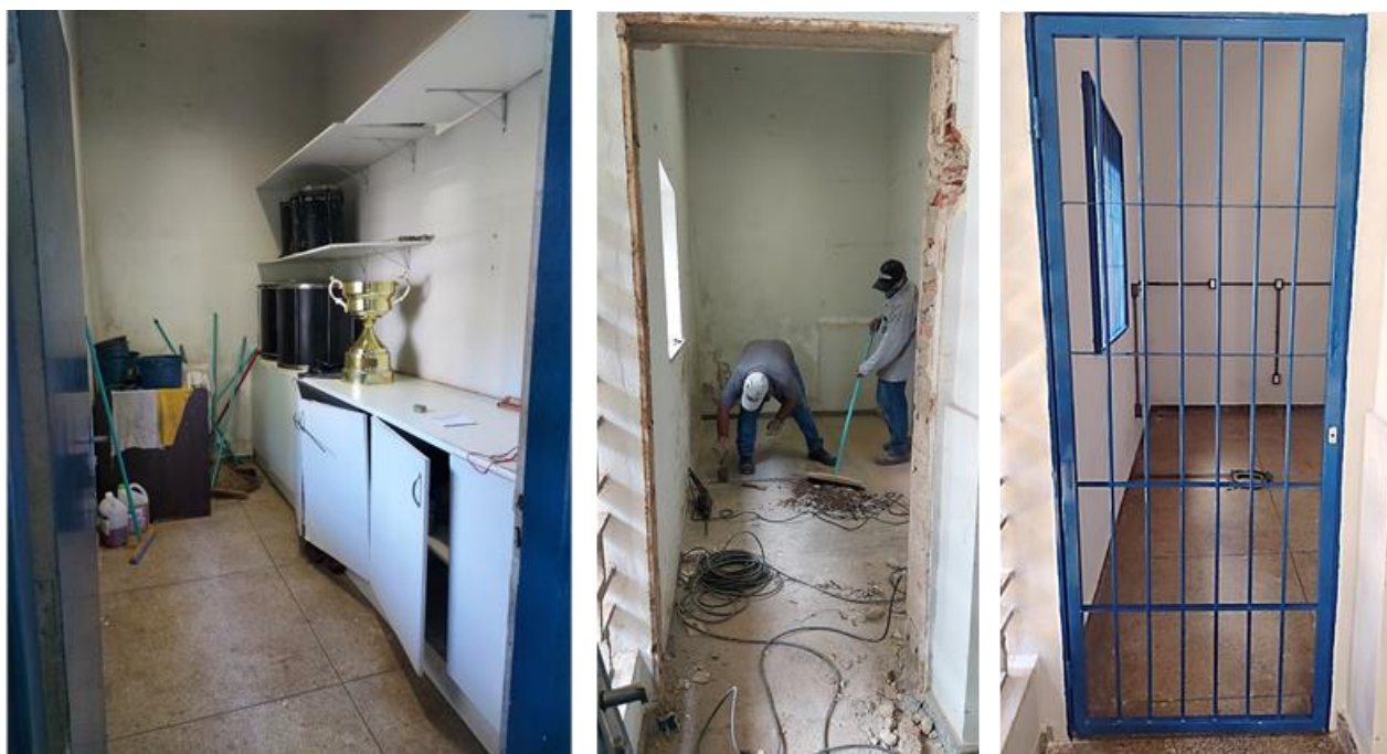
Foto 7 – Reforma da sala de baterias e inversor.
